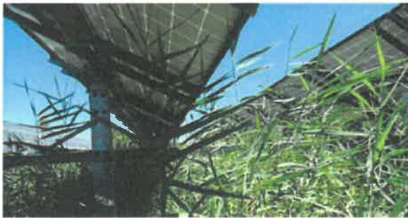
Roselière (zone humide) au sein de la centrale de Zabo (34)
